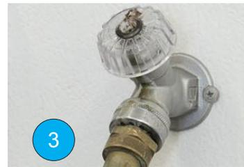
(FI) Kytke laitteen vedensyöttö.
